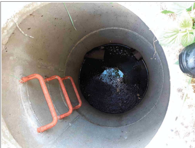
Regard drainage des eaux de la plateforme
